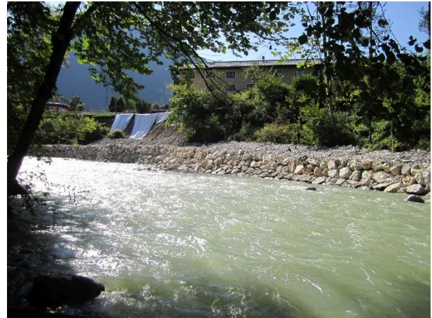
Abb. 4: Heute sorgt eine Ufersicherung dafür, dass die Königsseer Ache auch bei Hochwasser den Hang nicht mehr unterspülen kann. Das Hotel kann wieder Gäste empfangen.
